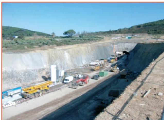
[Fig. 1] .- Depuradora inicial para el tratamiento de 15m 3 /hora.
